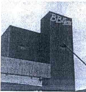
La torre della B.B. Farm.
